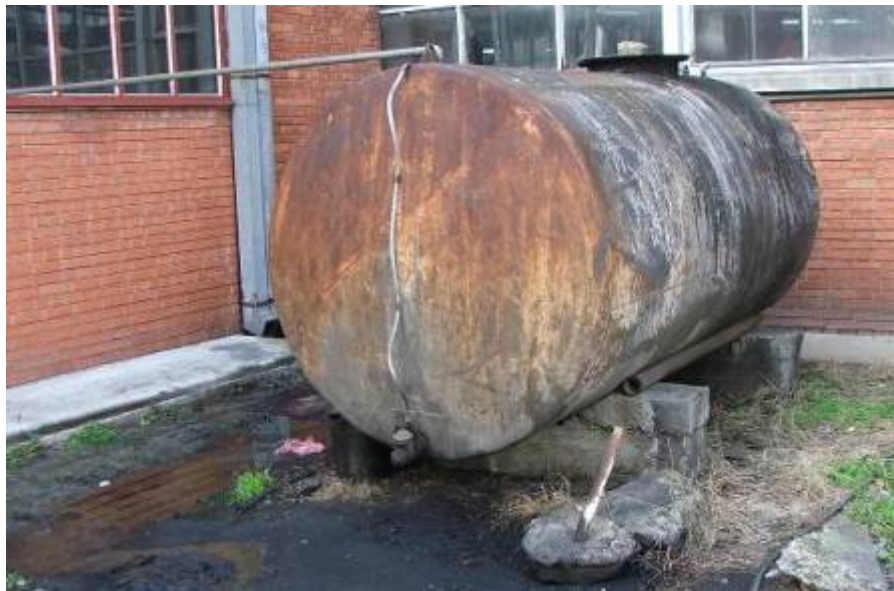
Слика 19 - Резервоар запремине 5000 l за прикупљање отпадног уља
