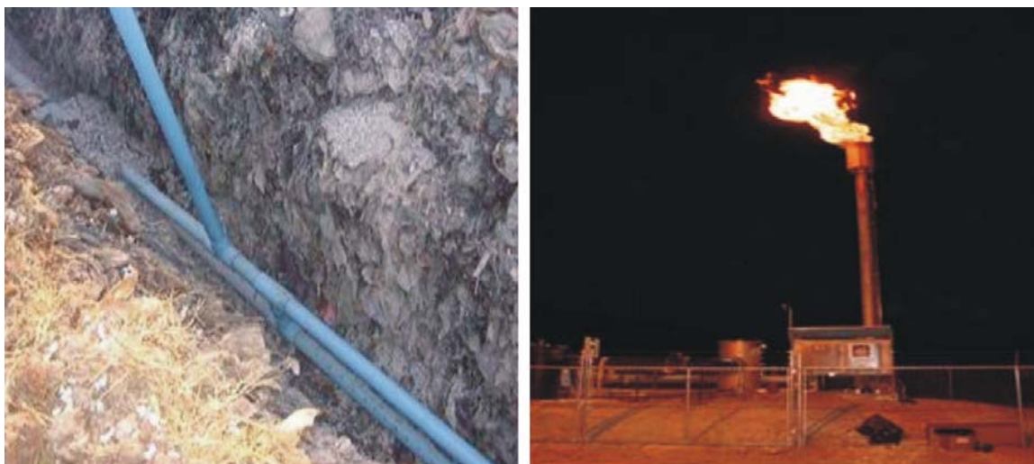
Слика 2 - Систем сакупљања и сагоревања депонијског гаса
