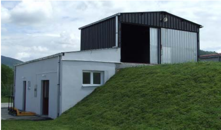
Слика 68 - Сабирни пункт (хладњаца) за привремено складиштење кланичког отпада - Вршац
